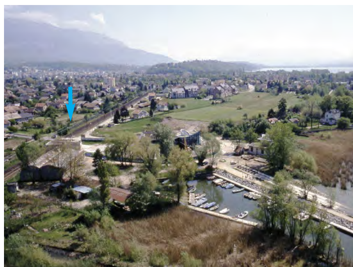
^ L'ancien chantier naval. Vue aérienne, vers 1995. (AC Aix-les-Bains)
