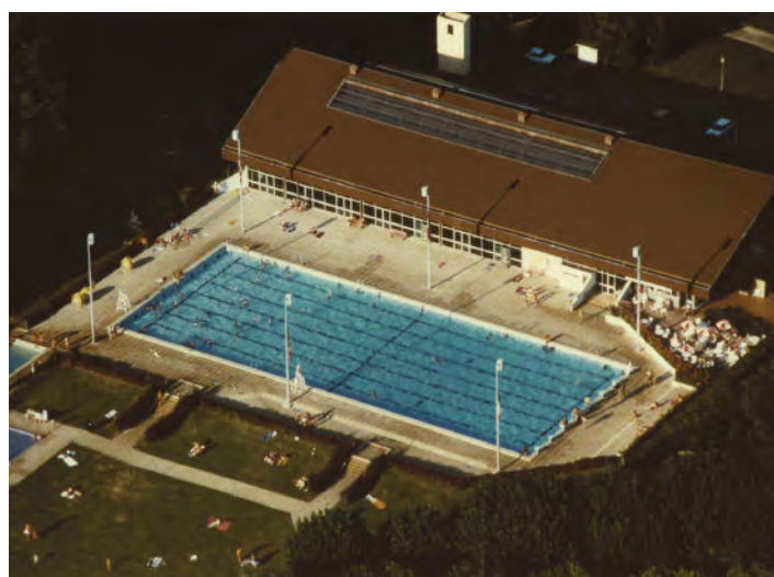
^ La piscine municipale, vers 1985. (AC Aix-les-Bains)
