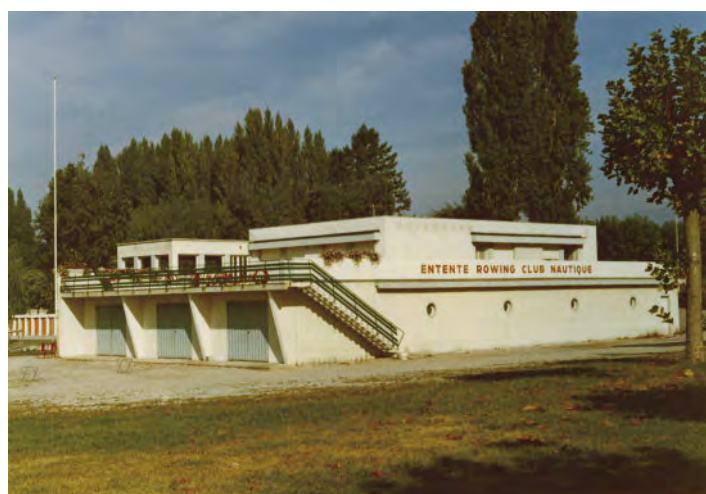
^ Le garage du Rowing, vers 1970. (AC Aix-les-Bains)
