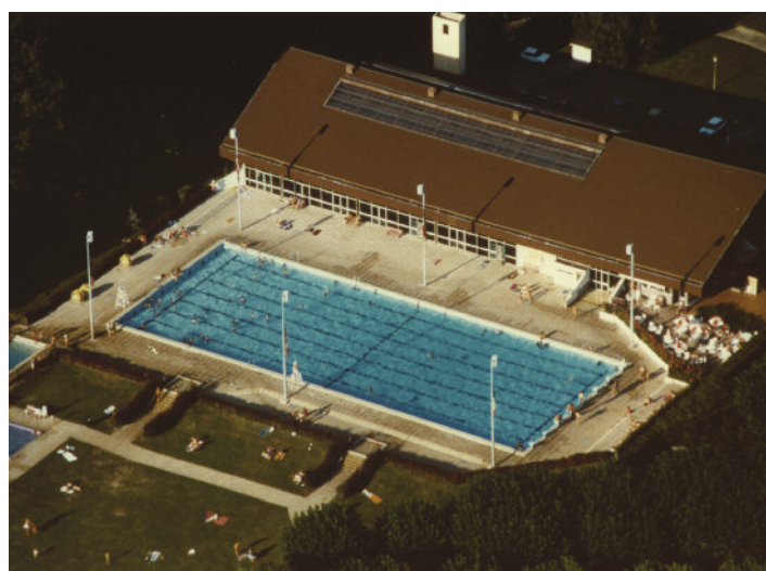
^ La piscine municipale, vers 1985. (AC Aix-les-Bains)
